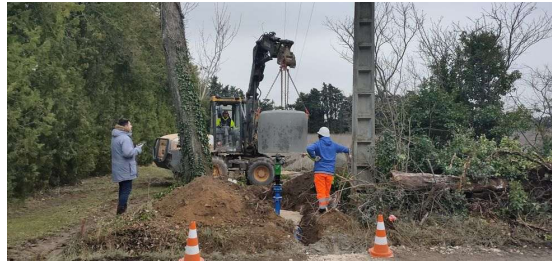
Pose d'un rond de puits sur borne
