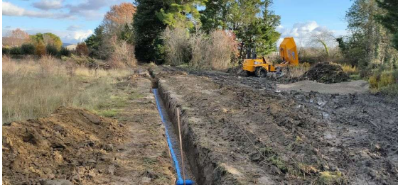
Tranchée pour pose de canalisation secteur Filiole 31
