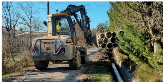
Démarré en novembre 2023, ces travaux de mise sous pression de nos réseaux concernent essentiellement la zone encadrée par la RD 25 de Caumont à l'Isle au Nord et le chemin du Petit Hôpital / chemin de Montfavet au Sud. Ce sont pas moins de 95 branchements qui sont prévus pour être raccordés au réseau pression, constitué pour partie de la réutilisation d'un réseau gravitaire enterré existant et de nouveau réseau.
