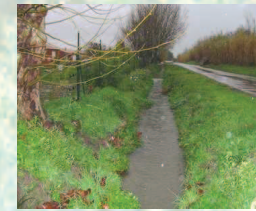
Filiole du canal lors d'une pluie
